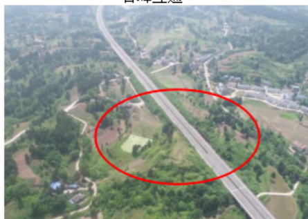
板桥枢纽互通
