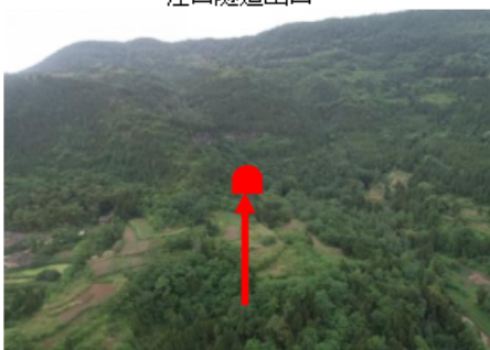
长岭寨隧道起点
