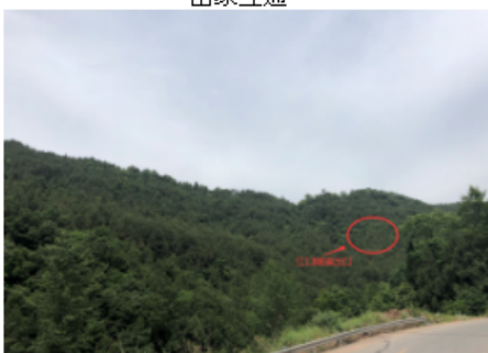
江口隧道出口
