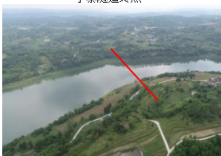
鸡公石渠江特大桥
