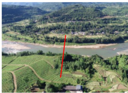
东山通江河特大桥
