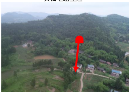
小寨隧道终点
